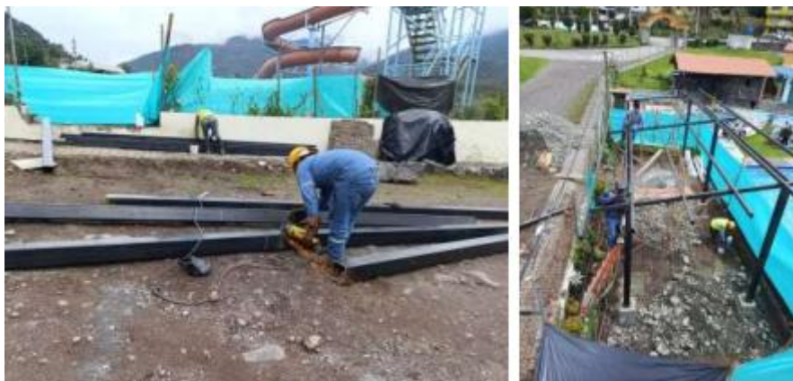
Fotografía No. 9. Preparación de estructura metálica
