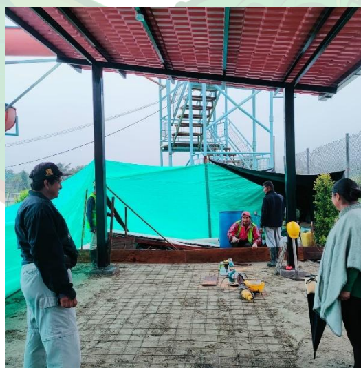
Fotografía No. 11. Colocación de malla electrosoldada.
