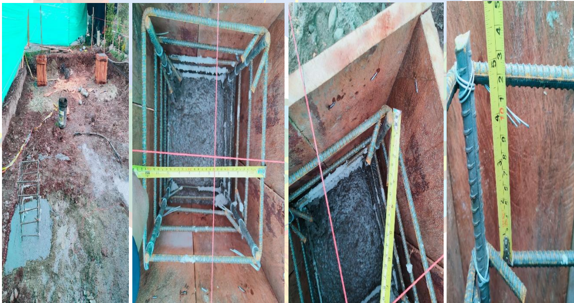
Fotografía No. 4. Figurado ya armado de acero de refuerzo in situ.
