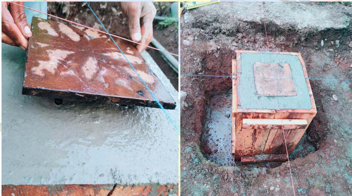
Fotografía No. 5. Revisión placas de anclaje. e=10\text{mm} soldado y pintado.
