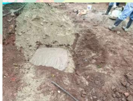
Fotografía No. 3. Hormigón en replantillo f'c kg/cm2
