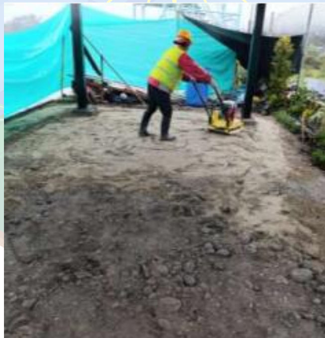
Fotografía No.7. Relleno de material.
