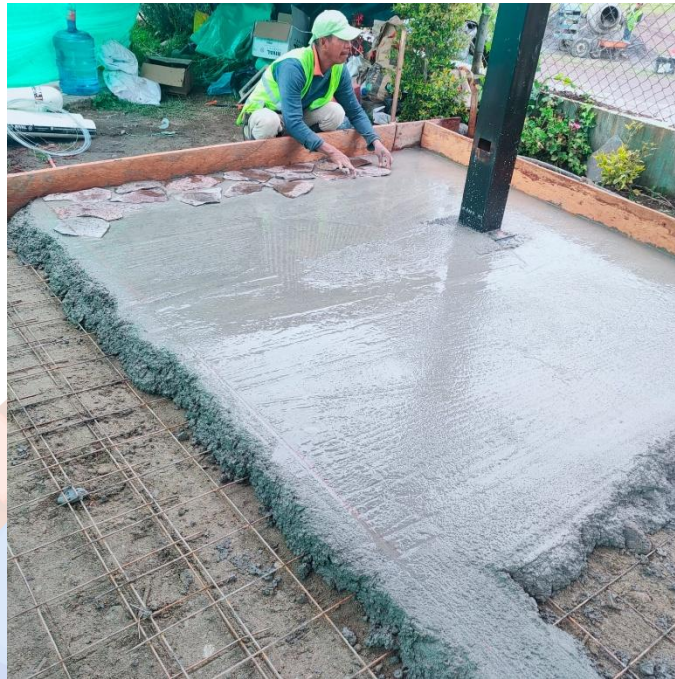
Fotografía No. 12. Colocación de piedra laja.
