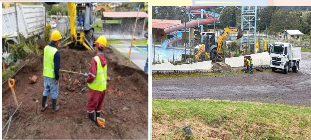
Fotografía No. 2. Desalojo mecánico volqueta y retroexcavadora
