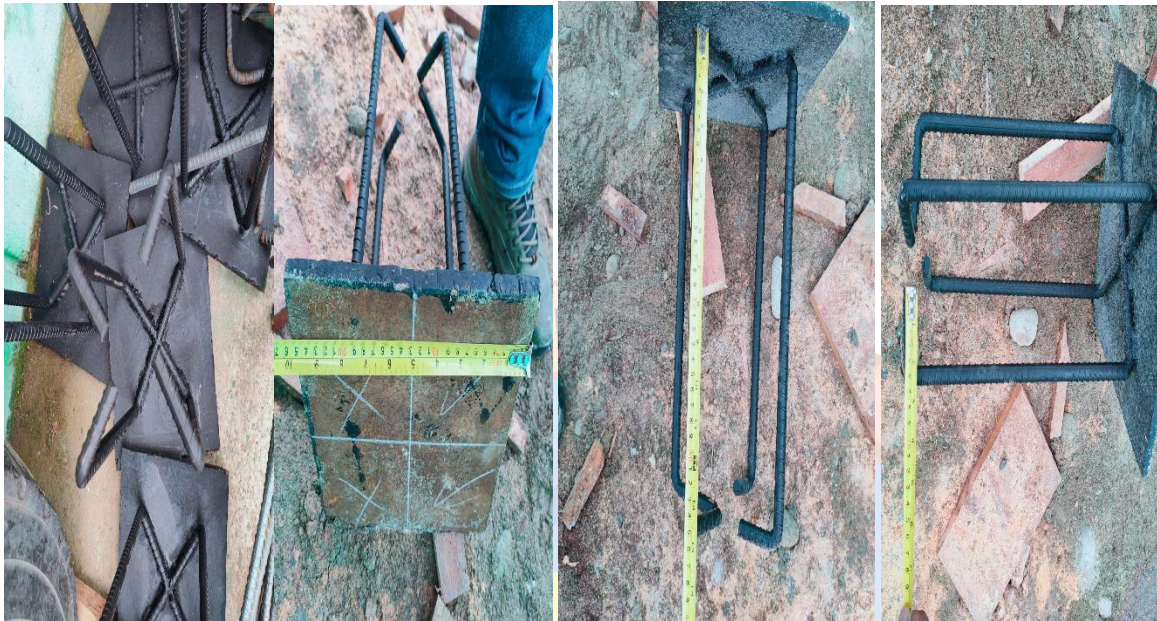
Fotografía No. 5. Revisión placas de anclaje. e=10\text{mm} soldado y pintado.
