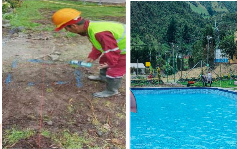
Fotografías No. 1. Replanteo, nivelación y excavación manual.
