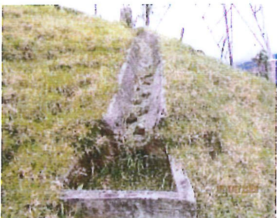
Foto 11. Zona de descarga de aguas de Escorrentía superficial.
