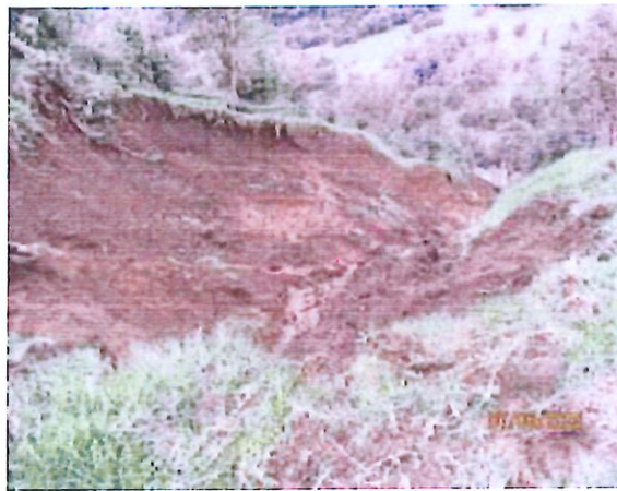
Foto 10. Remoción en masa recurrente aguas de la torre para tendido eléctrico.
