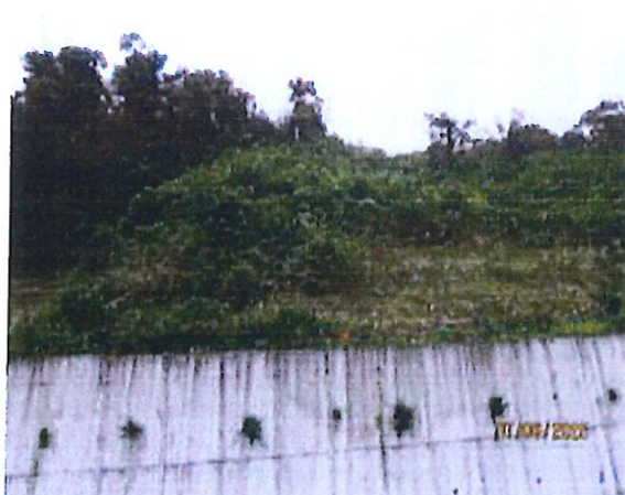
Foto 5. Muro de contención construido para proteger tubería de Hidrovictoria.
