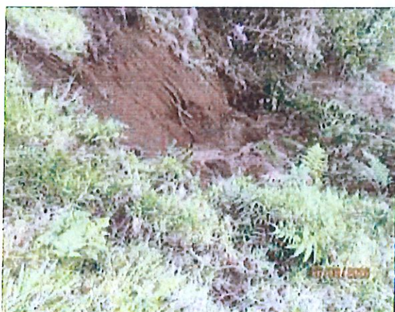
Foto 3. Deslizamiento ocurrido aguas arriba de la planta de tratamiento de agua.
