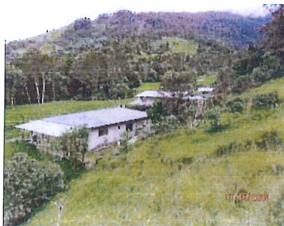
Foto 2. Presencia de grietas en la vertiente aguas arriba de la planta de agua.
